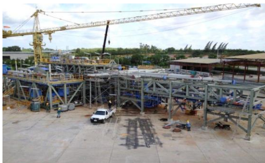
งานแปรรูปและประกอบกลุ่มชิ้นงานขนาดใหญ่ –อุตสาหกรรมก๊าซ โครงการ APLNG – Pre Assemble Unit ประเทศออสเตรเลีย
