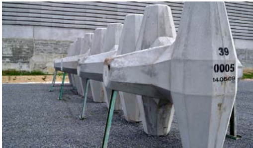
ชิ้นส่วนเชื่อมกันชายฝั่งจากคลื่นทะเล (Breakwater) โครงการ Sino Iron Cape Preston Breakwater ประเทศออสเตรเลีย
