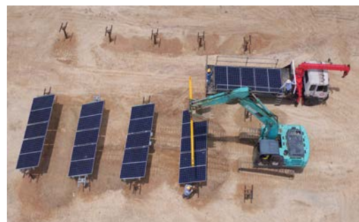
งานโครงสร้างเหล็ก – อุตสาหกรรมพลังงานแสงอาทิตย์ โครงการ SunSHIFT ประเทศออสเตรเลีย
