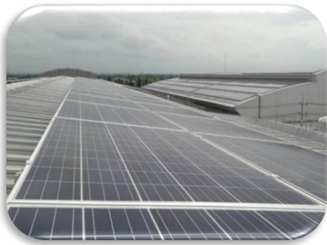
การติดตั้งแผงโซลาร์เซลล์บนหลังคาอาคารโรงงาน
