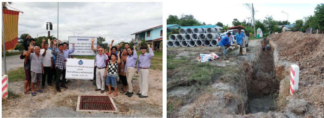
ฝังท่อระบายน้ำพร้อมบ่อพักที่บ้านสระบัวกำ หมู่ที่ 7 เป็นเงิน 135,000.- บาท เพื่อช่วยเหลือชุมชน ให้สามารถระบายน้ำออกสู่ภายนอกได้สะดวก ป้องกันน้ำท่วมขังในหมู่บ้านในฤดูฝน ตามโครงการ “ความร่วมมือเพื่อการพัฒนาชุมชน สังคม และสิ่งแวดล้อมอย่างยั่งยืน” ประจำปี 2562
