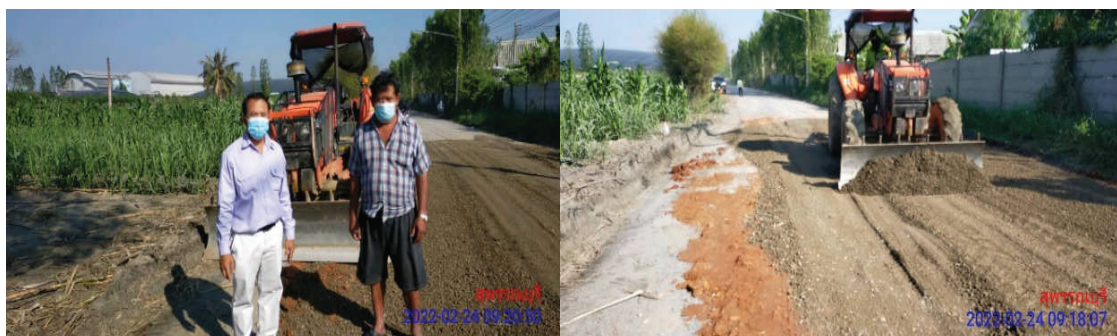
ภาพ : นำลูกรังและหินคลุกเข้าทำการซ่อมแซมปรับปรุงถนนสายบ้านวังน้ำโจน
