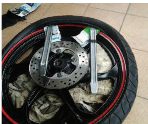
รูปที่ 4 : การประกอบยางนอก ชนิด Tubeless กับกระทะล้อ
