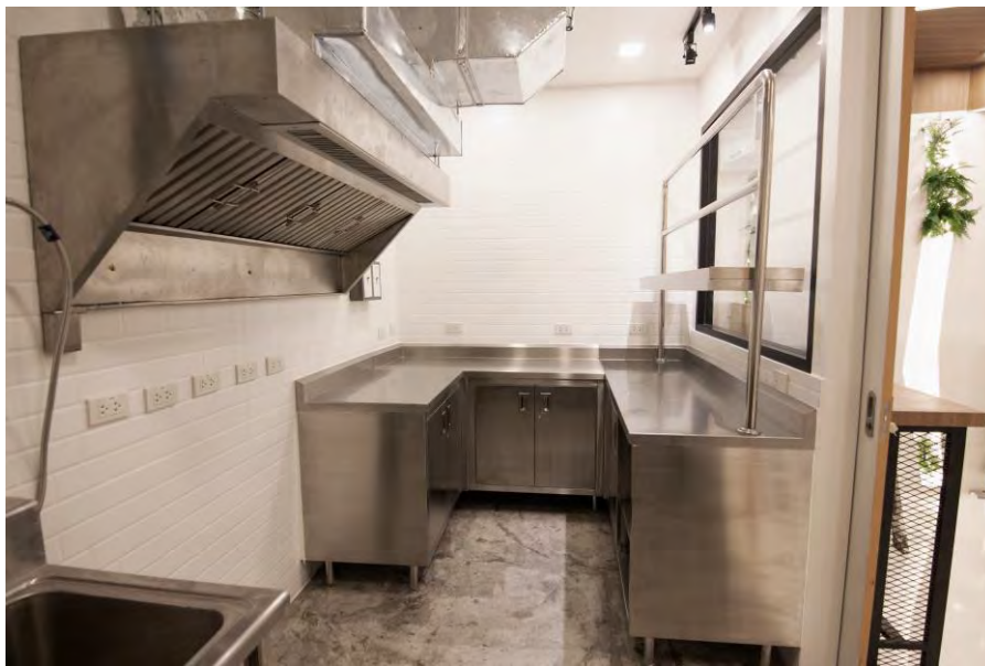
งานผลิตและติดตั้งชุดครัวสแตนเลสภายในครัว
