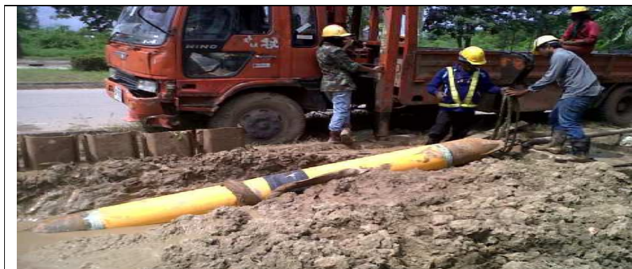
การขุดเจาะแบบไม่เปิดหน้าดิน (HDD)
