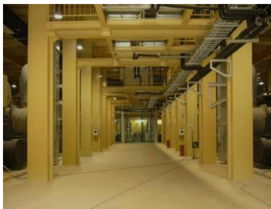
โครงสร้างเหล็กสำหรับระบบน้ำหล่อเย็น (Chilled Water System) โครงการ Discovery Gardens District Cooling Plant ประเทศสหรัฐอาหรับเอมิเรตส์
