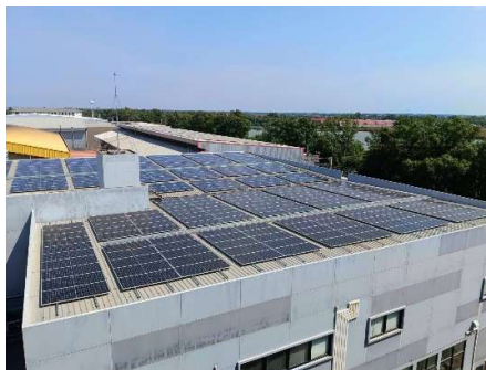
การติดตั้งระบบผลิตไฟฟ้าจากพลังงานแสงอาทิตย์ (Solar Rooftop) บนหลังคาอาคารโรงงาน
