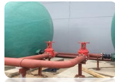
งานติดตั้งท่อสูบล ระบบดับเพลิง
