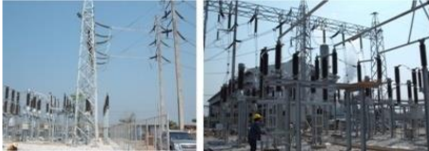
ภาพถ่าย 115 kV. Substation (สถานีไฟฟ้าย่อย) พร้อมระบบ PLC เชื่อมโยงกับระบบ การรายงานผลและควบคุมผ่านเส้นใยนำแสง
