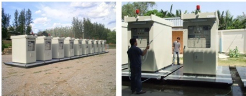
ภาพถ่าย Motor Starter Panel ขนาดไฟแรงดัน 6,600 Volt ที่สามารถเคลื่อนย้ายได้
