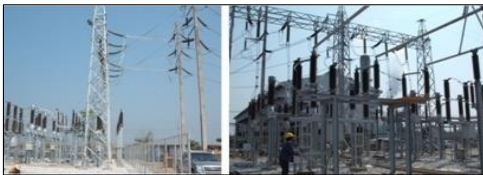
ภาพแสดง 115 kV. Substation (สถานีไฟฟ้าย่อย) พร้อมระบบ PLC เชื่อมโยงกับระบบการรายงานผล และควบคุมผ่านเส้นใยนำแสง
