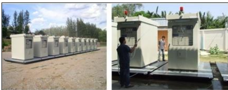
ภาพแสดง Motor Starter Panel ขนาดไฟแรงดัน 6,600 Volt ที่สามารถเคลื่อนย้ายได้
