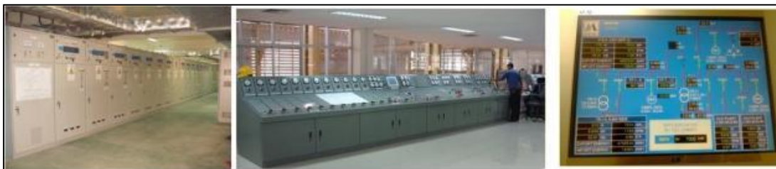
ภาพแสดงระบบ Switchgear Panel พร้อมระบบ PLC และการสื่อสารกับระบบรายงานผลจากคอมพิวเตอร์
