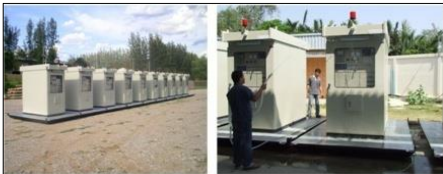
ภาพแสดง Motor Starter Panel ขนาดไฟแรงดัน 6,600 Volt ที่สามารถเคลื่อนย้ายได้
