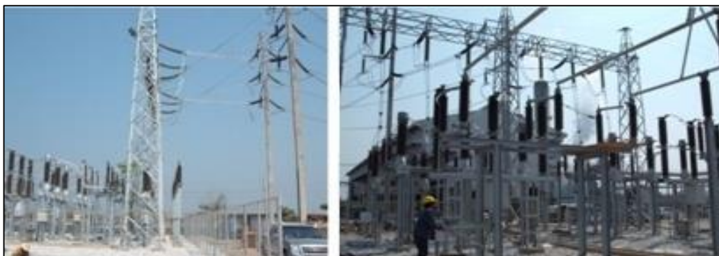
ภาพแสดง 115 kV. Substation (สถานีไฟฟ้าย่อย) พร้อมระบบ PLC เชื่อมโยงกับระบบการรายงานผล และควบคุมผ่านเส้นใยนำแสง
