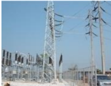
ภาพแสดง 115 kV. Substation (สถานีไฟฟ้าย่อย) พร้อมระบบ Network IEC61850 เชื่อมโยงกับระบบการรายงานผล และควบคุมผ่านเส้นใยนำแสง
