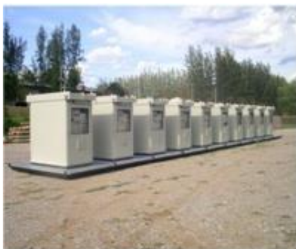
ภาพแสดง Motor Starter Panel ขนาดไฟแรงดัน 6,600 Volt ที่สามารถเคลื่อนย้ายได้
