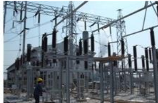
ภาพแสดง 115 kV. Substation (สถานีไฟฟ้าย่อย) พร้อมระบบ Network IEC61850 เชื่อมโยงกับระบบการรายงานผล และควบคุมผ่านเส้นใยนำแสง
