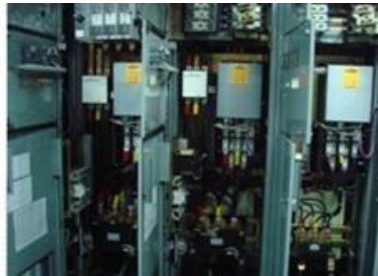
ภาพแสดงการเปลี่ยนระบบการควบคุมเครื่องจักรเก่าโดยการเปลี่ยนเป็น Digital Drives พร้อมระบบ PLC
