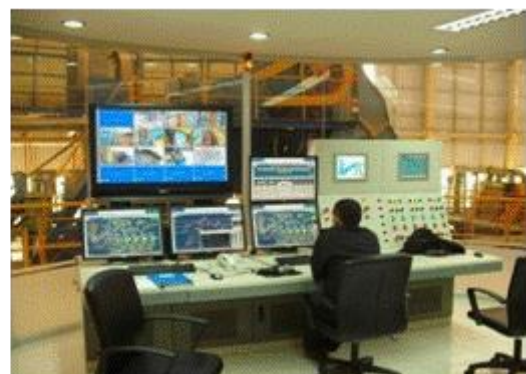
ภาพแสดงระบบควบคุมความเร็วพร้อม Motor ขนาด 1,500 kW. และ 630 kW. พร้อมระบบ PLC และการสื่อสารกับระบบรายงานผลจากคอมพิวเตอร์
