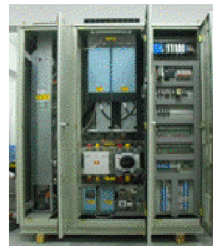
ภาพแสดงระบบ Regenerative Inverter ควบคุมความเร็วโดยระบบ PLC และการสื่อสารกับระบบรายงานผลจากคอมพิวเตอร์
