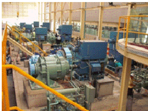
ภาพแสดงระบบควบคุมความเร็วพร้อม Motor ขนาด 1,500 kW. และ 630 kW. พร้อมระบบ PLC และการสื่อสารกับระบบรายงานผลจากคอมพิวเตอร์
