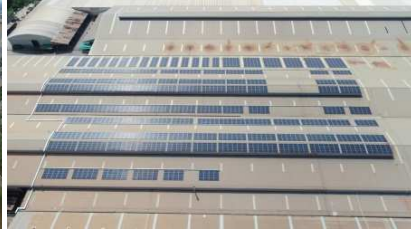
ระบบ PV Solar Rooftop ขนาด 0.9 MW ที่โรงงานหนองแคว1
