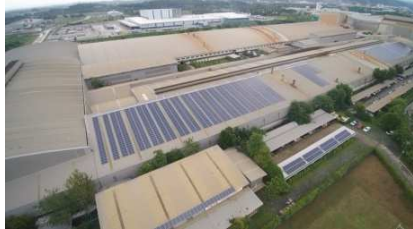
ระบบ PV Solar Rooftop ขนาด 1.8 MW ที่โรงงานนิคมหนองแคว
