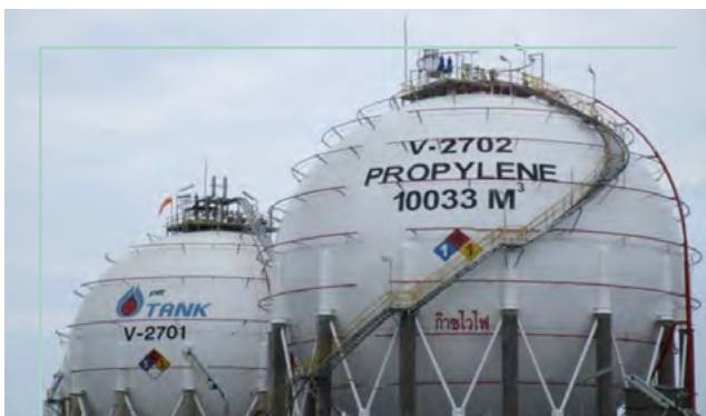
โครงการสร้างถังบรรจุโพลีโพรพิลีนทรงกลมขนาด 4,000 ตัน New Propylene Storage Tank
