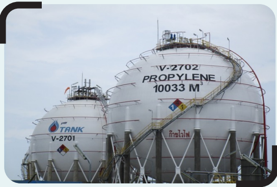
โครงการสร้างถังบรรจุโพลีโพรพิลีนทรงกลม ขนาด 4,000 ตัน New Propylene Storage Tank
