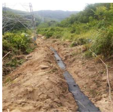
การจัดวางระบบรากสายดินแบบ Counterpoise และการใช้ MEG หุ้มรอบสายตัวนำ
