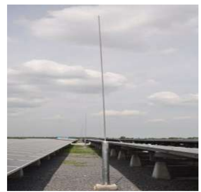
การติดตั้ง Lightning Pole เพื่อป้องกัน แผง PV Module จากการถูกฟ้าผ่า
