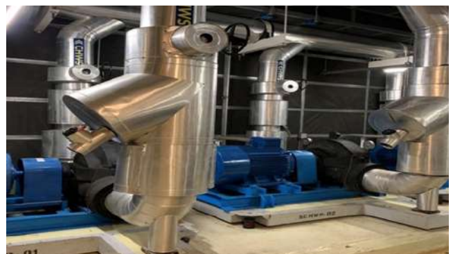
ปรับความเร็วรอบของมอเตอร์บีบน้ำเย็น-น้ำหล่อเย็นให้เหมาะสม
