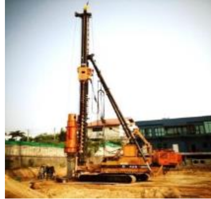
รูปภาพการตอกเสาโดยปั้นจั่นชนิดไฮดรอลิกแฮมเมอร์
