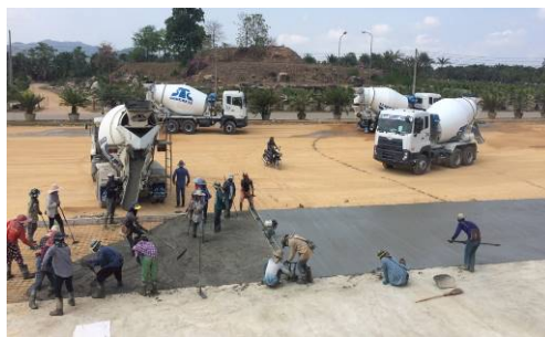
รูปภาพตัวอย่างหน้างานการเทคอนกรีตผสมเสร็จ
