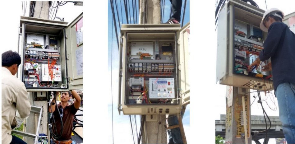
การติดตั้งและวางระบบ FRTU
