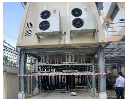
สถานีไฟฟ้าย่อยแบบคอนเทนเนอร์
