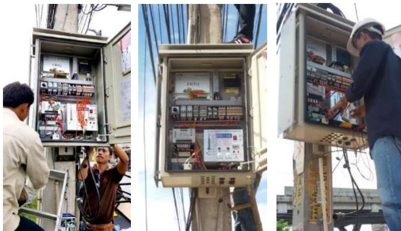
การติดตั้งและวางระบบ FRTU
