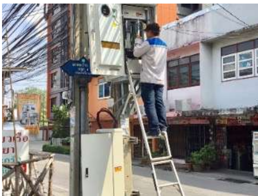
การติดตั้ง และวางระบบอุปกรณ์ MSAN
