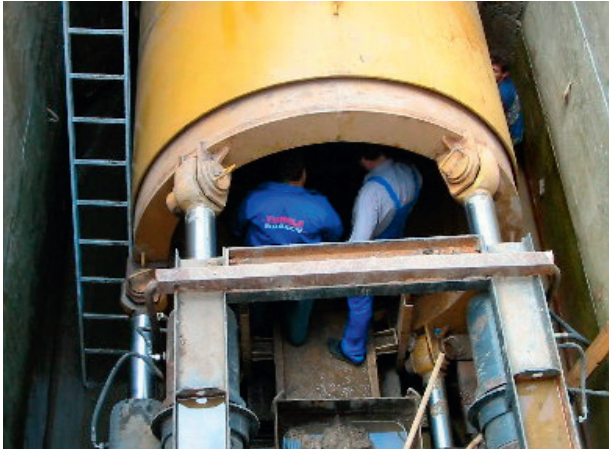
งานก่อสร้างท่อร้อยสายไฟฟ้าใต้ดิน โดยวิธีการดันท่อลอด (Pipe Jacking Method) บริเวณถนนแพรงษา จังหวัดสมุทรปราการ
