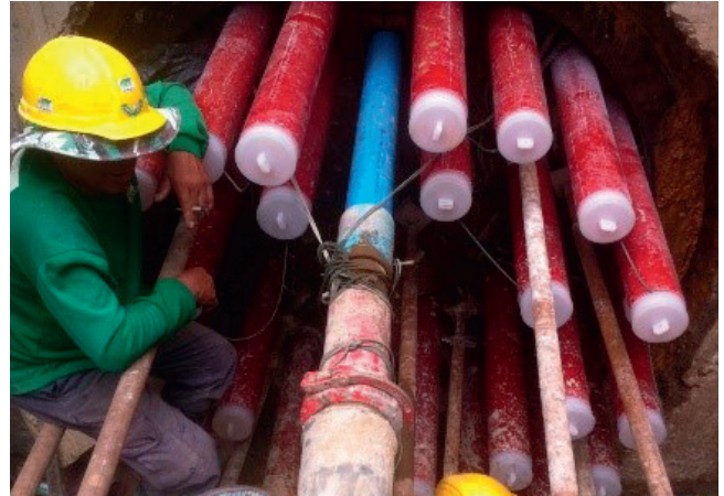
งานก่อสร้างท่อร้อยสายไฟฟ้าใต้ดิน โดยวิธีการดันท่อลอด (Pipe Jacking Method) บริเวณถนนแพรงษา จังหวัดสมุทรปราการ
