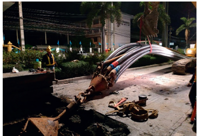
งานก่อสร้างท่อร้อยสายไฟฟ้าใต้ดิน โดยวิธีเจาะและดึงท่อ (Horizontal Directional Drilling Method) บริเวณโครงการรถไฟฟ้าสายสีเหลือง กรุงเทพมหานคร
