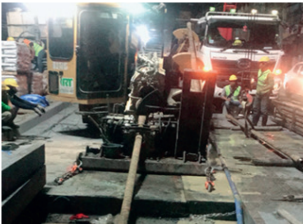
งานก่อสร้างท่อร้อยสายไฟฟ้าใต้ดิน โดยวิธีเจาะและดึงท่อ (Horizontal Directional Drilling Method) บริเวณโครงการรถไฟฟ้าสายสีเหลือง กรุงเทพมหานคร
