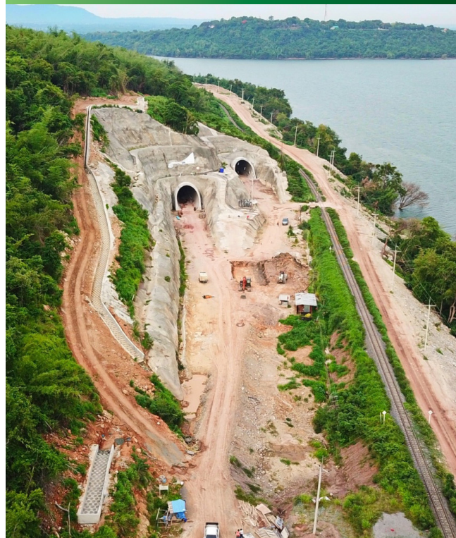
งานก่อสร้างอุโมงค์โครงการรถไฟรางคู่ ช่วงชุมทาง มาบะเบา-จิระ จังหวัดสระบุรี-จังหวัดนครราชสีมา
