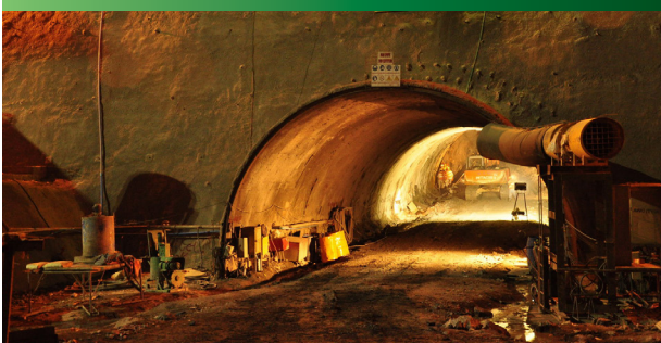
งานก่อสร้างอุโมงค์ส่งน้ำโครงการโรงไฟฟ้าเทายักัด (2) ประเทศพม่า Horse shoe shaped (Top-heading)
