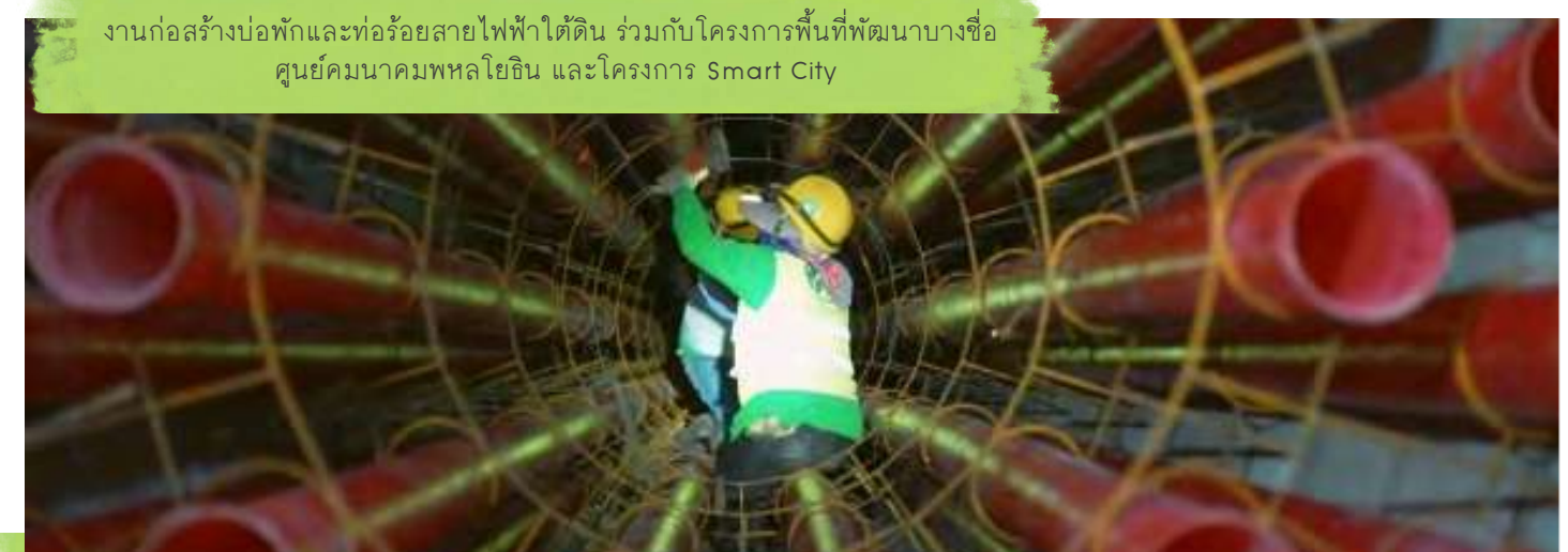
งานก่อสร้างบ่อพักและท่อร้อยสายไฟฟ้าใต้ดิน ถนนแพรงษา จังหวัดสมุทรปราการ
