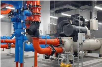
งานระบบปรับอากาศแบบน้ำเย็น (Chiller)
