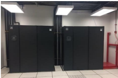
ระบบปรับอากาศแบบควบคุมอุณหภูมิ และความชื้น (CRAC)
