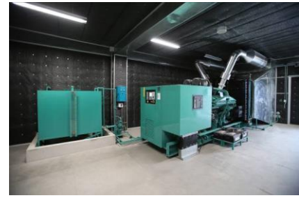
งานระบบไฟฟ้าสำรอง (เครื่องกำเนิดไฟฟ้า)
