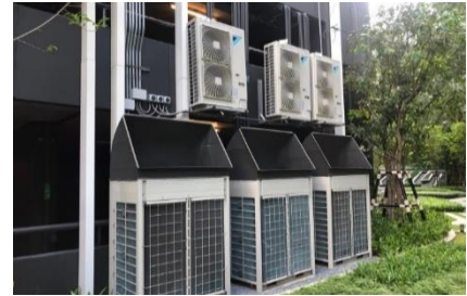
งานเครื่องปรับอากาศแบบแยกส่วน (Split Type)
