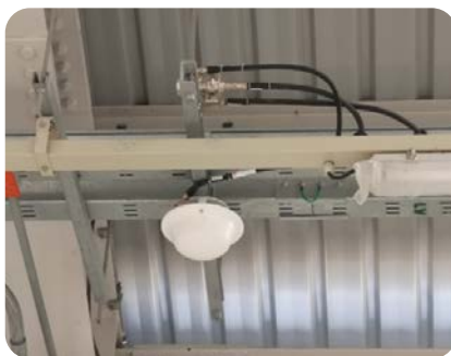
การติดตั้ง DRS Antenna สำหรับโครงการรถไฟฟ้า
