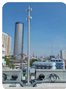
การติดตั้งระบบสื่อสารไร้สาย BWDS สำหรับโครงการรถไฟฟ้า
