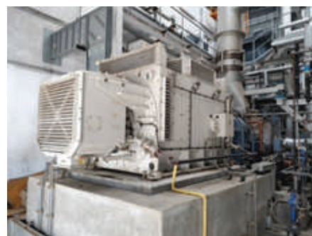
กังหันไอน้ำ และเครื่องกำเนิดไฟฟ้า (Turbine & Generator)
