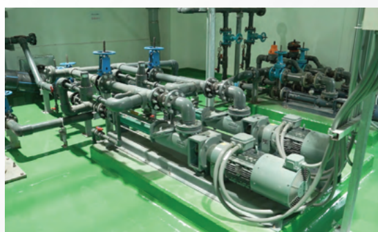
งานจัดหาและติดตั้งเครื่องสูบน้ำ
