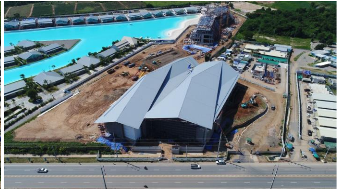
ภาพการก่อสร้างสปอร์ต คลับ
