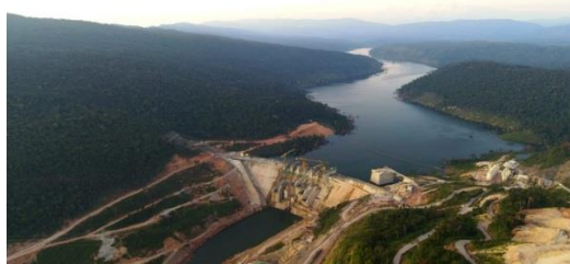
โครงการโรงไฟฟ้าน้ำเทิน 1 (น้ำเทิน 1)
