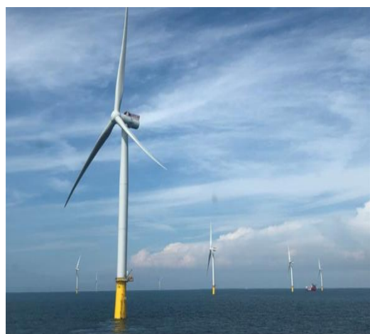
โครงการโรงไฟฟ้าหมุนเวียน (หมุนเวียน)
